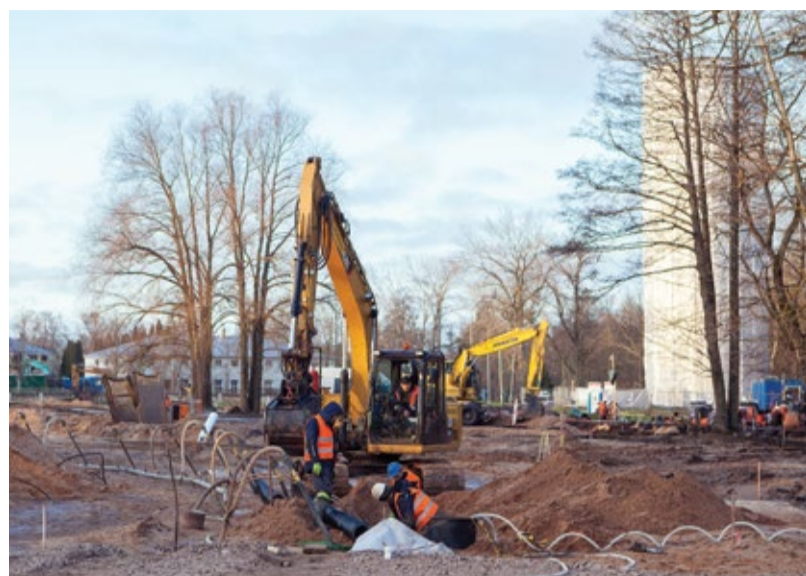
Stāvvietas izbūve Emīla Dārziņa ielā.
