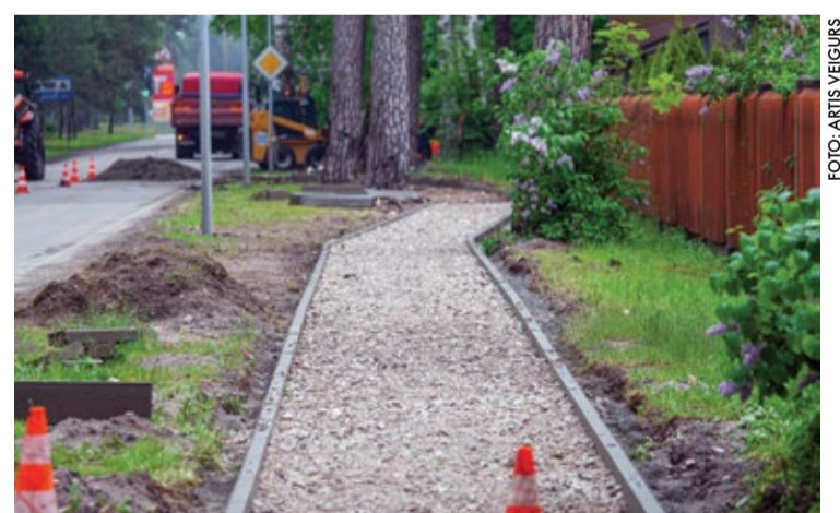
Gājēju ietvju atjaunošana uzsākta Strēlnieku prospektā no Alauksa ielas līdz Lielupes ielai (upes pusē).
