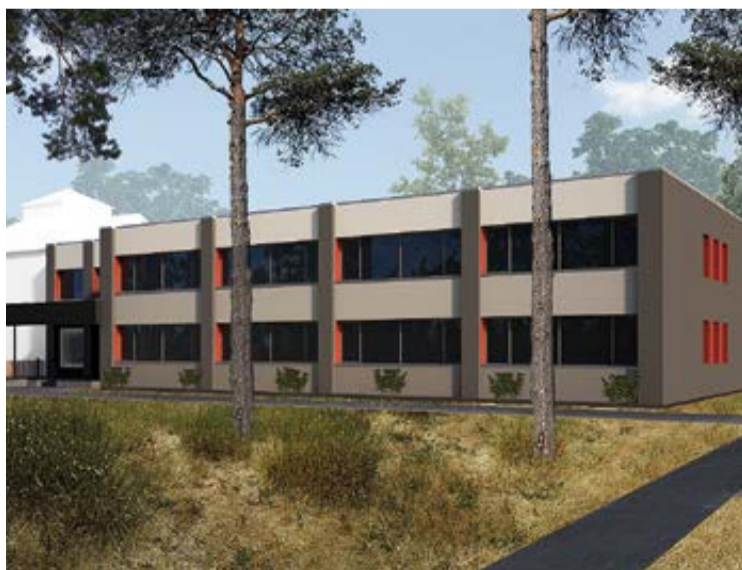
Pēc pasākumiem ēkas energoefektivitātes paaugstināšanai tiks atjaunota arī tās fasāde.
