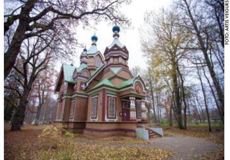
Ķemeru pareizticīgo baznīca atjaunojusi ēkas galveno fasādi, vēl atlicis sakārtot pārējo fasādes daļu. To draudze iecerējusi paveikt nākamajā gadā.
