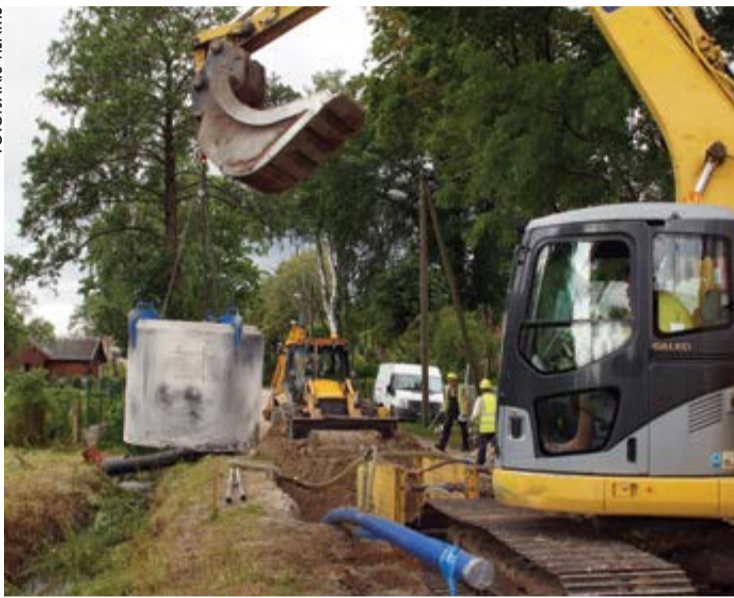
Maģistrālo cauruļvadu izbūve ir garš un darbietilpīgs process. Darbu noslēgumā tiks veikta cauruļvadu sistēmu hidrauliskā pārbaude.
