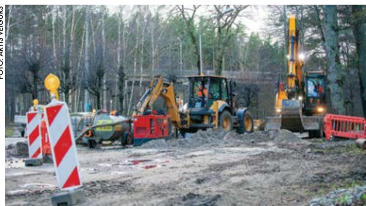
Jūrmalas ūdenssaimniecības attīstības projekta IV kārtā tīkla izbūves darbi notiek gandrīz visos pilsētas rajonos.
