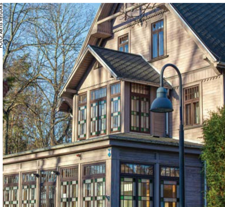
Jūrmalas Tūrisma informācijas centra jaunizveidotie maršruti ved pa Dubultu ieliņām, aicinot saskatīt Jūrmalas koka arhitektūras daudzveidību.
