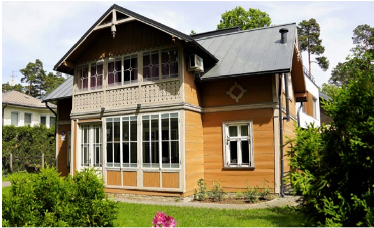
Koka dzīvojamā māja Kaudzīšu ielā. Restaurācijas procesā atjaunota lielākā daļa oriģinālo detaļu, kā arī saglabāta ēkas planku sienu konstrukcija, kas šodien kalpo kā akcents, stāstot par mājas seno būvēsturi.
