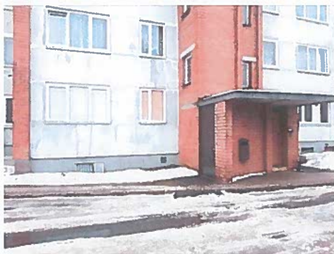
Skats uz kāpņu telpas durvīm
