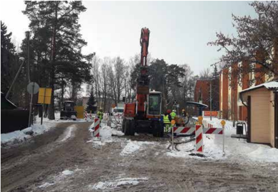
Apjomīgi būvdarbi norisinās daudzās pilsētas apkaimēs. Attēlā – būvdarbi Ķemeru ielā.
