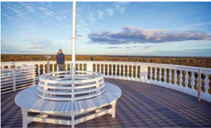
Uz torņa jumta ir izbūvētas skatu platformas, uzstādīts tālskatis.
