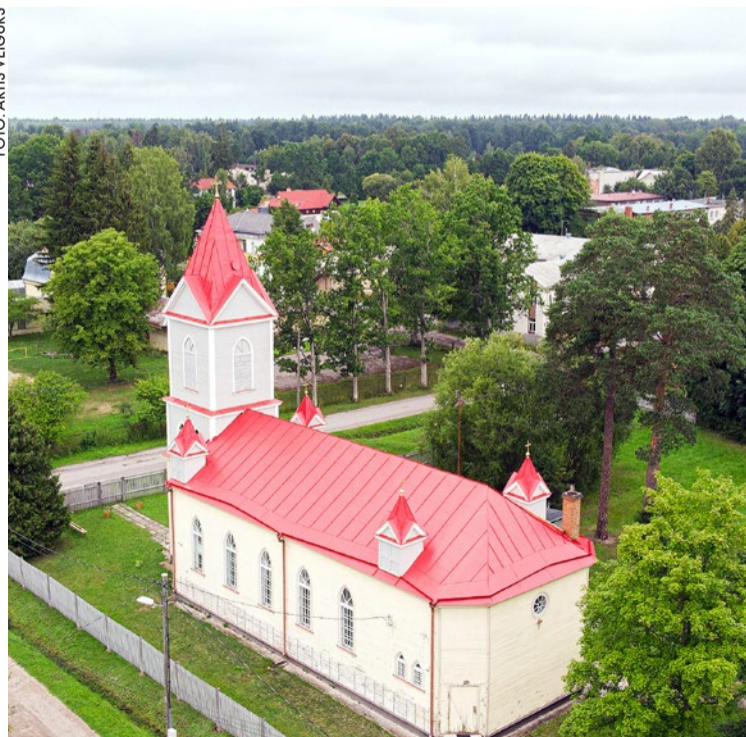
Ar pašvaldības līdzfinansējumu pakāpeniski tiek atjaunota Ķemeru katoļu baznīca Sēravotu ielā.
