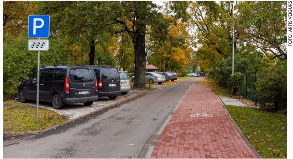
Baznīcas ielas posmā no Slokas ielas līdz Dubultu prospektam atjaunota brauktuve, ielas malā izbūvētas stāvvietas automašīnām, otrā ielas pusē izbūvēts veloceliņš.
