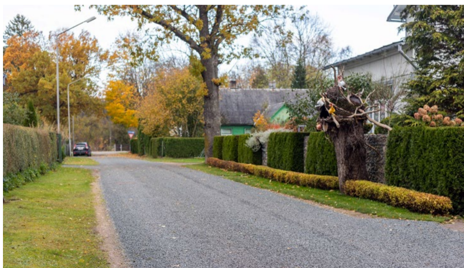
Grantēto ielu stāvokļa uzlabošanai izmantota jauna tehnoloģija – ielu dubultās virsmas apstrāde ar bitumena un granīta šķembu maisījumu. Attēlā – Liesmas iela.
