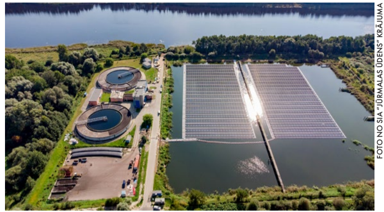
Saules enerģijas stacija Slokā izvietota ūdens attīrīšanas baseinā uz ūdens virsmas.
