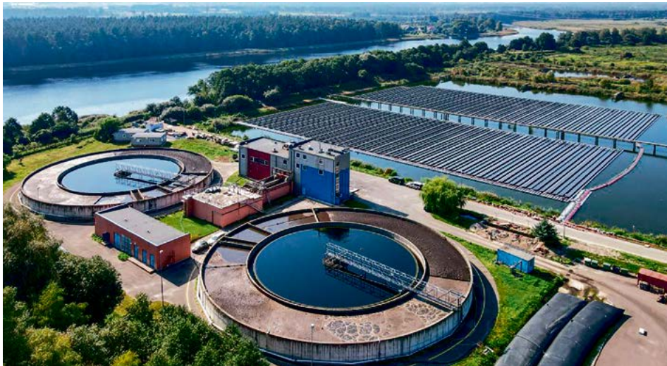
Saules enerģijas stacija izvietota uz peldošiem pontoniem pārplūdes dīķī Slokas notekūdeņu attīrīšanas iekārtu teritorijā.
