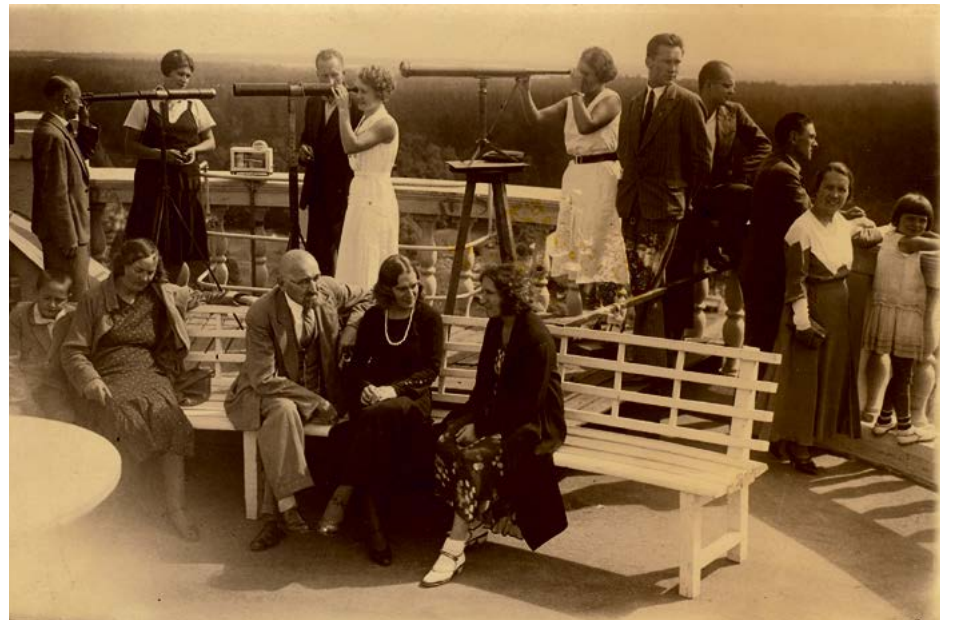
20. gs. 30. gadi. Ķemeru ūdenstorna skatu platforma – iecienīts kūrorta viesu apmeklējuma objekts.
