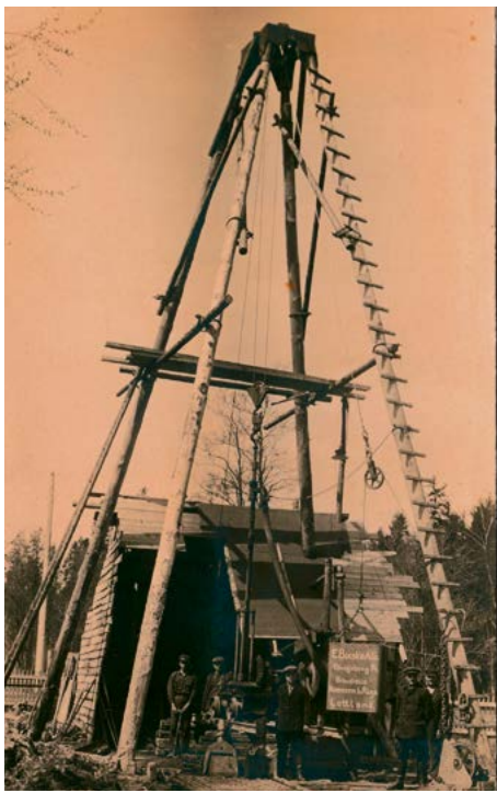
20. gs. 20. gadu otrā puse. Ūdenstorna celtniecība Ķemeru, akas rakšana.
