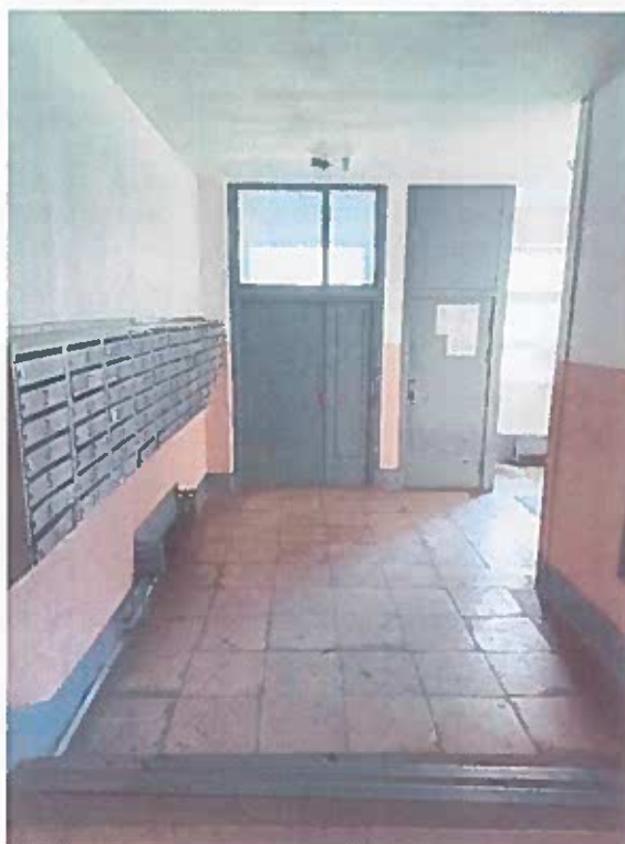
Skats uz kāpņu telpu
