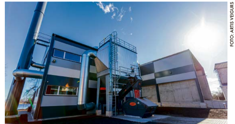
SIA "Jūrmalas siltums" katlumāja Slokas ielā 47A ieguvusi 2. vietu skatē "Gada labākā būve Latvijā 2023" nominācijā "Publiska jaunbūve. Ražošanas ēka".
