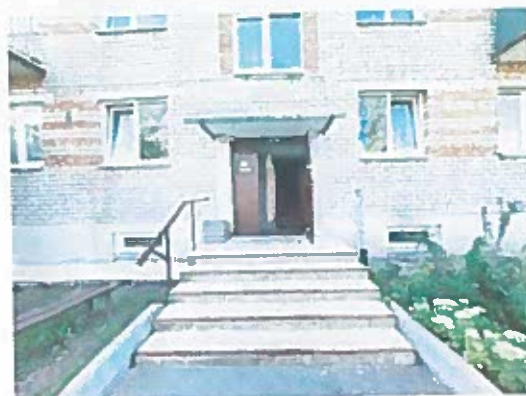
Skats uz kāpņu telpas durvīm
