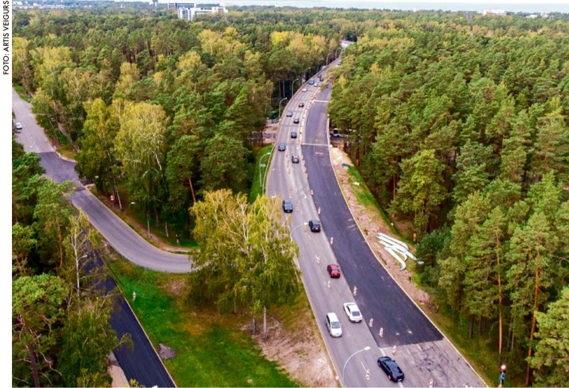
Pabeigti būvdarbi Dzintaru dzelzceļa pārvada labajā pusē virzienā no Rīgas uz Majoriem, no šā gada 14. oktobra būvdarbi tiks sākti pārvada kreisajā pusē. Tiks noteikti jauni satiksmes ierobežojumi.
