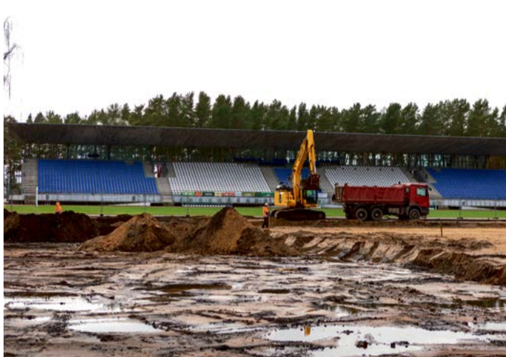
Būvdarbi stadiona "Sloka" sporta laukumu pārbūvei sākti pagājušā gada beigās, tos plānots pabeigt 2025. gada vasarā.
