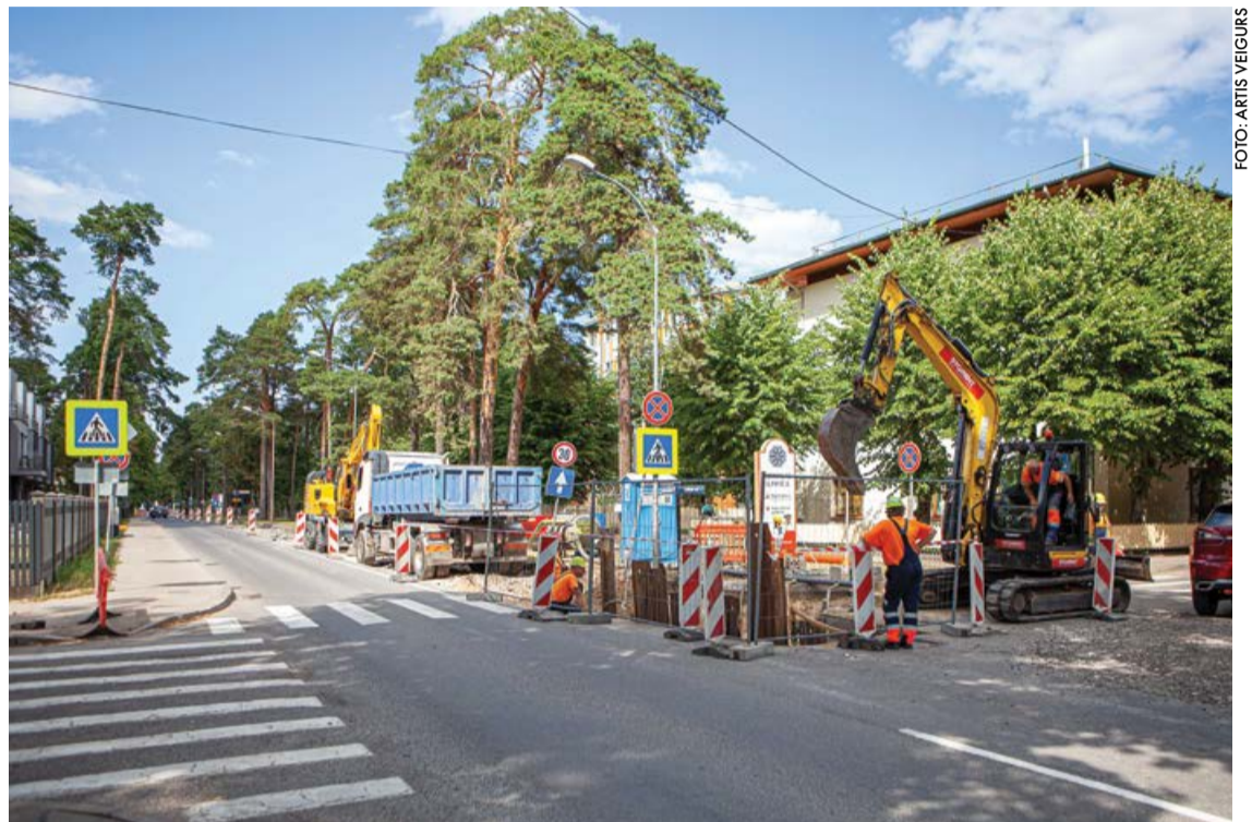
Aktīvi būvdarbi ūdensapgādes un kanalizācijas tīklu izbūvei šobrīd norisinās Vienības prospektā Bulduros. Tos plānots pabeigt līdz septembra vidum; līdz septembra beigām pabeigs ielas seguma atjaunošanu.
