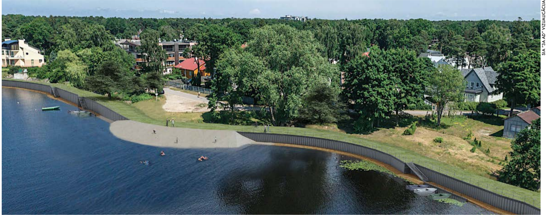
Izbūvējot aizsargbūves, tiks novērsti plūdu un krasta erozijas risku apdraudējums, kā arī nodrošināta kvalitatīvāka dzīves vide iedzīvotājiem.
